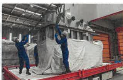
大型機器受入保管施設
