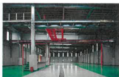
受入保管施設
